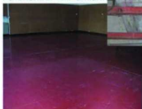
Pavimenti in vinil- amianto
